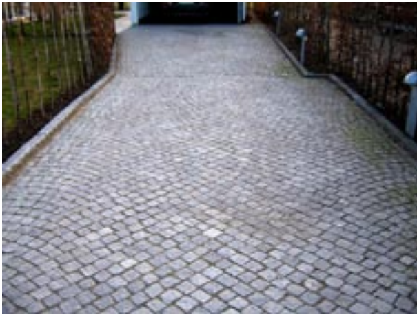
Fig 5.8 Diagonalsättning med smågatsten
