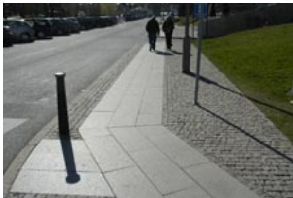
Fig 5.6 Rak stensättning med granithällar inlagda som gångyta.
