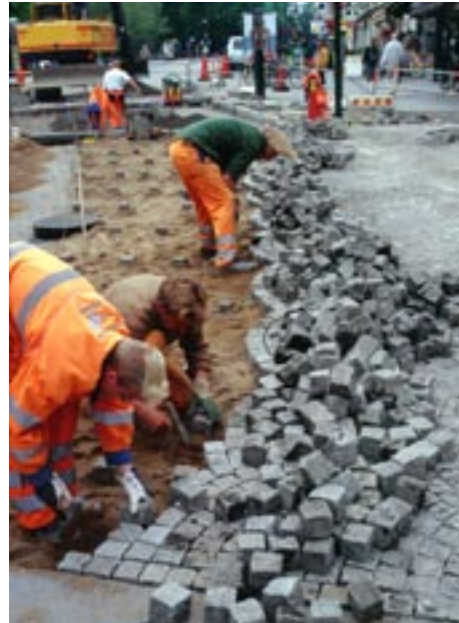
Fig 5.10 Bågsättning av smågatsten i sand
